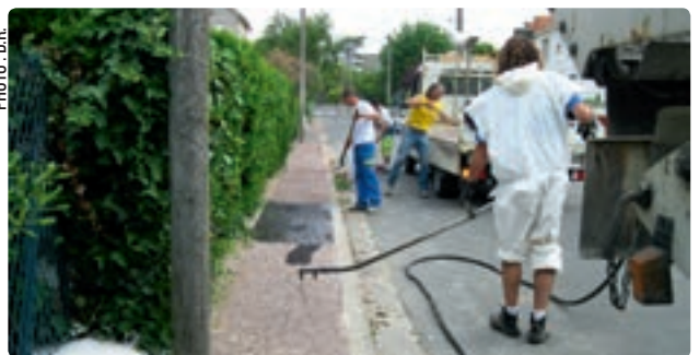
▼ Travaux de gravillonnage.
